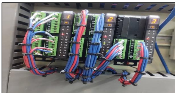
Figura 41. Conexión del Controlador EZ-ZONE RM.
