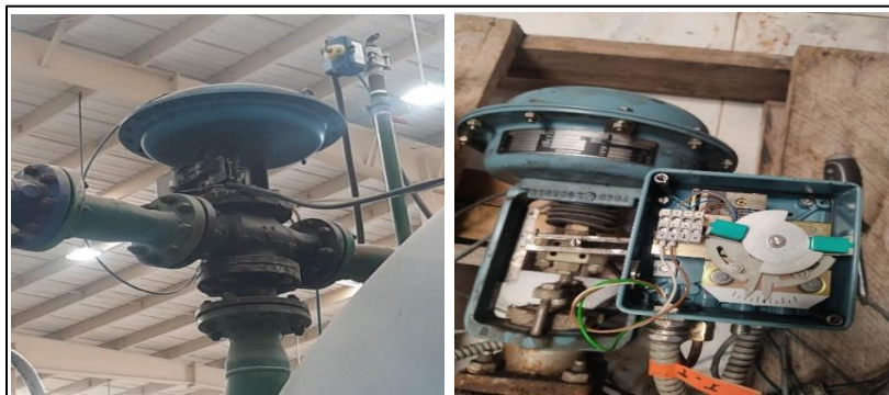
Figura 29. Válvula Modulante de Dos Pulgadas con Actuador de Aire para Entrada y Salida.
