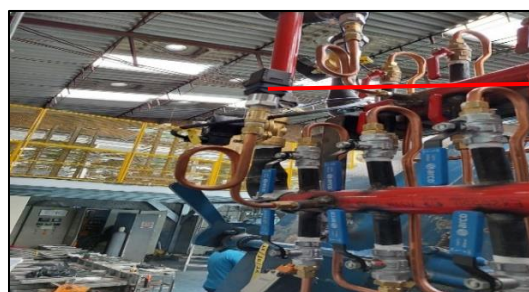
Figura 32. Transmisor de Presión de Vacío.
