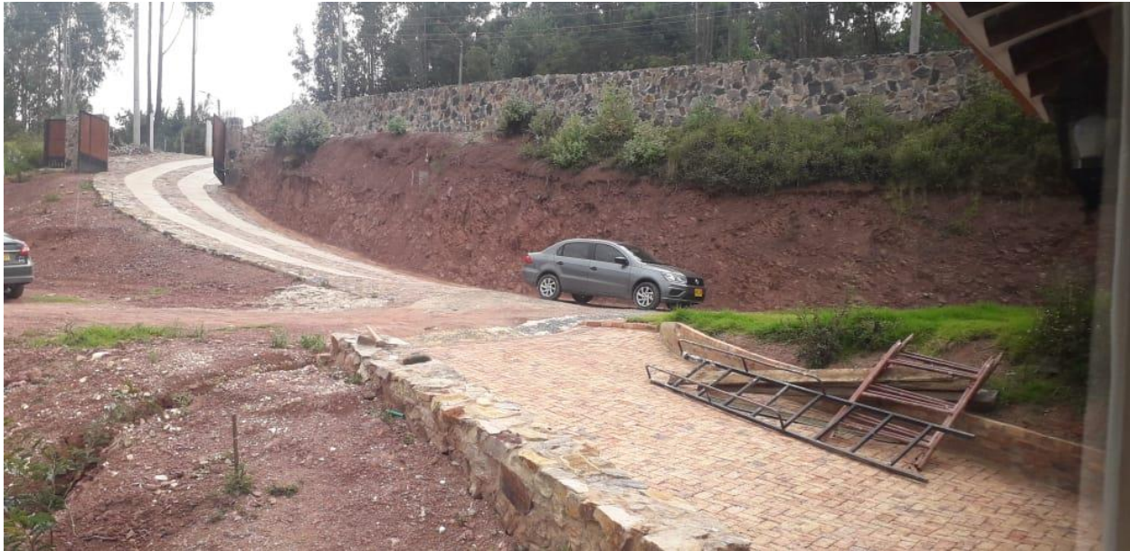
Imagen 13: Taludes Cabaña Dicho
