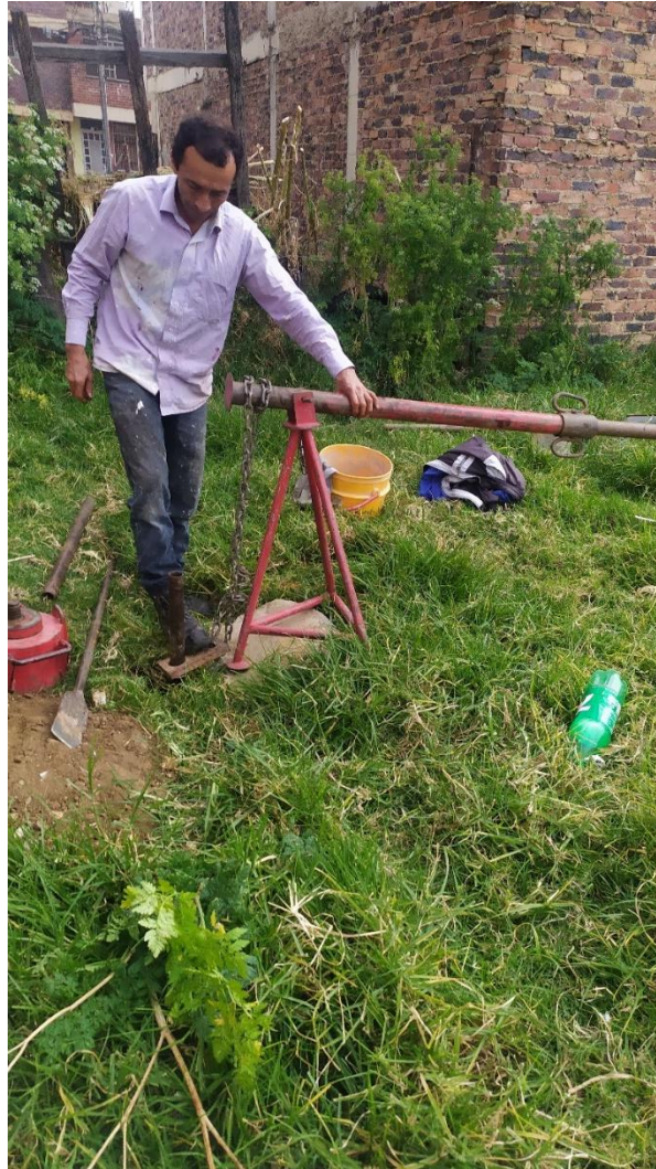
Imagen 16: Instalación equipo Sogamoso 01 03 2023.
