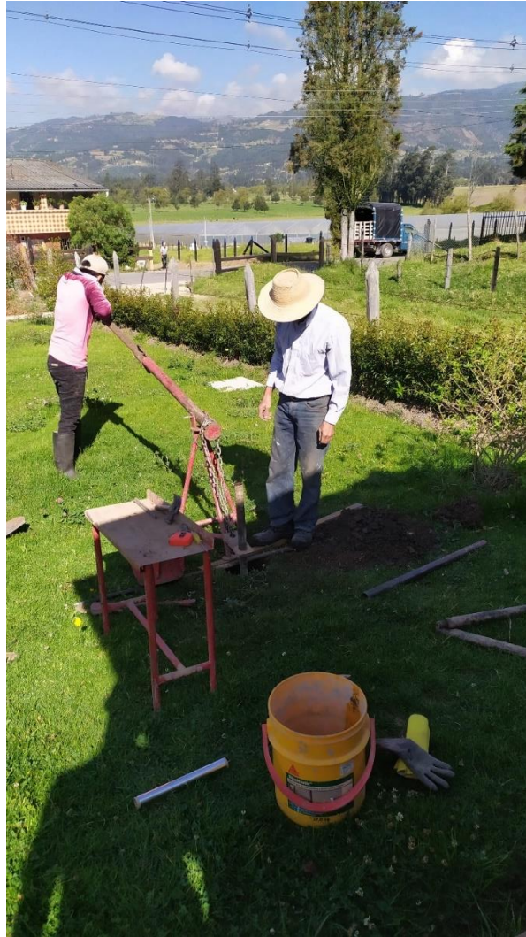
Imagen 30: Instalación equipo Vía la Trinidad 03 03 2023.
