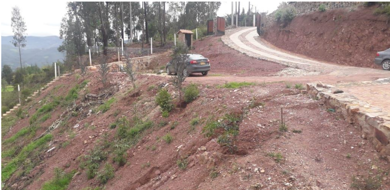
Imagen 14: Taludes Cabaña Dicho
