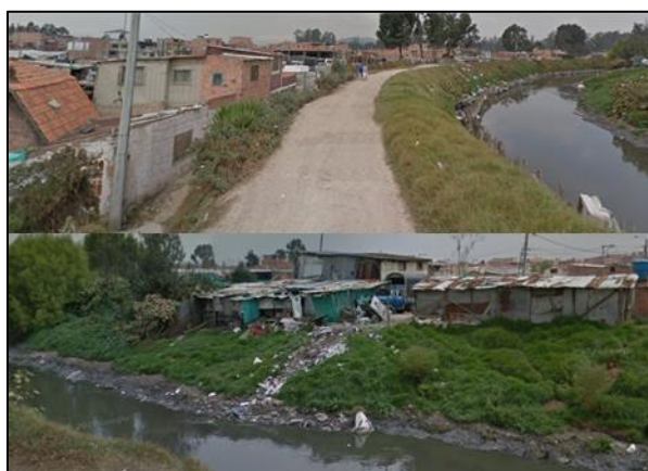
Figura 50. Evidencia fotográfica de afectaciones a la ronda de río en la zona de estudio.
