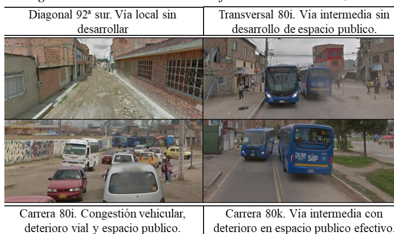
Figura 56. Imagen del estado actual de la infraestructura en la zona de estudio.
