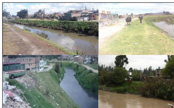
Figura 35. Imágenes de afectaciones en la ronda del río Tunjuelo.
