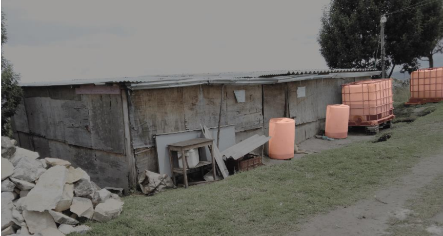
Fotografía 13: Suministro de agua.
