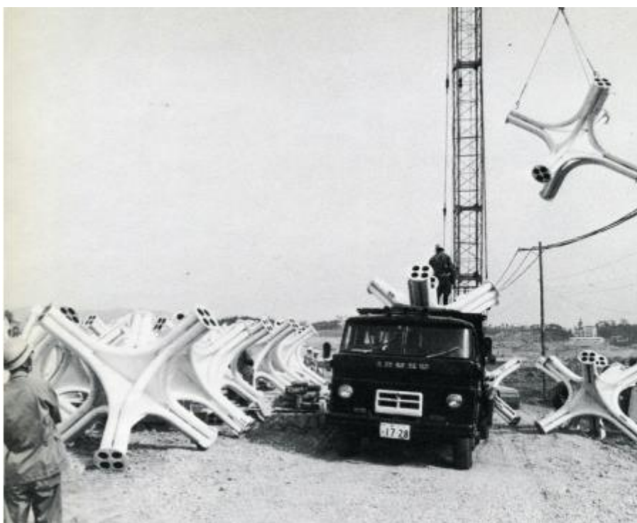
Imagen 20 : Proceso de instalación Pabellon Takara
