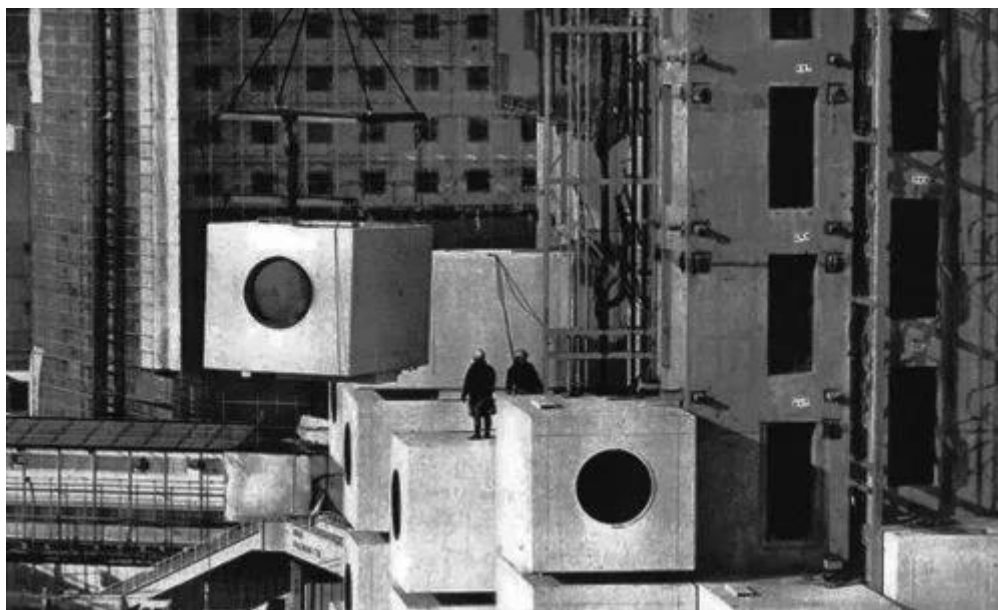
Imagen 35 : Instalacion de modulos torre negakin
