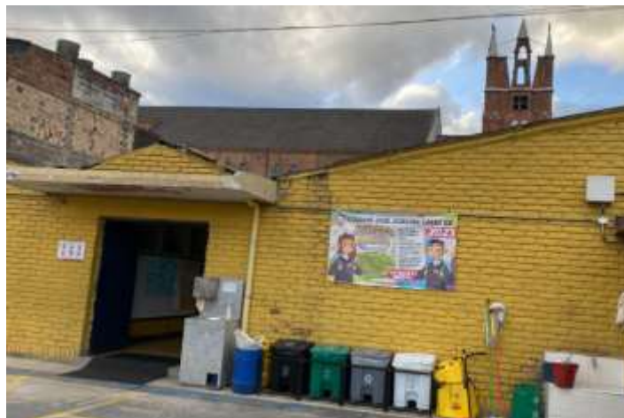
Figura 26. Evidencia fotográfica del muro de la IED José Joaquín Casas
