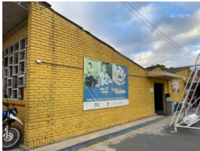
Figura 25. Evidencia fotográfica del muro de la IED José Joaquín Casas
