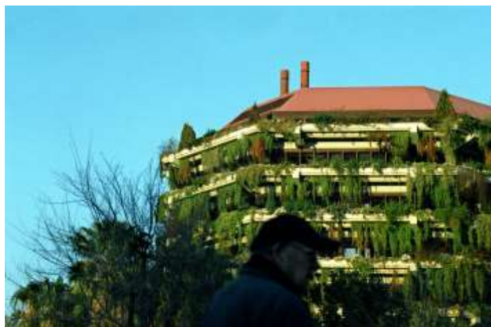
Figura 4. Edificio de Banca Catalana Barcelona
