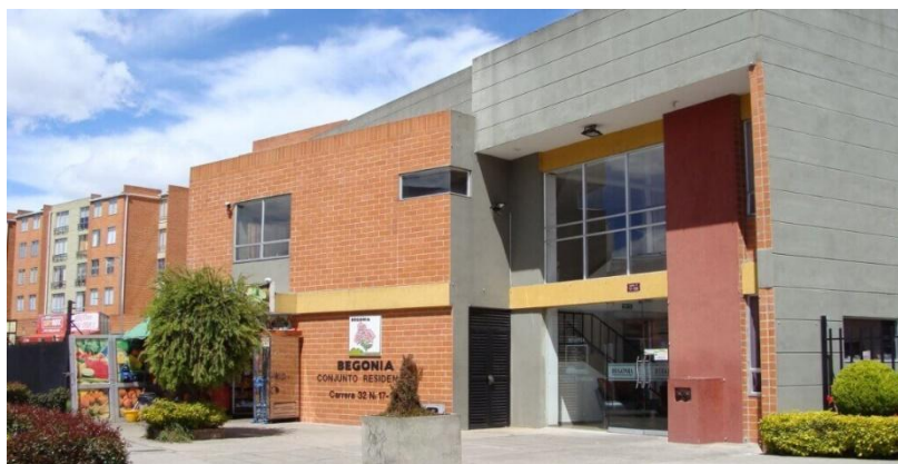
Figura 8. Conjunto residencial Begonia
