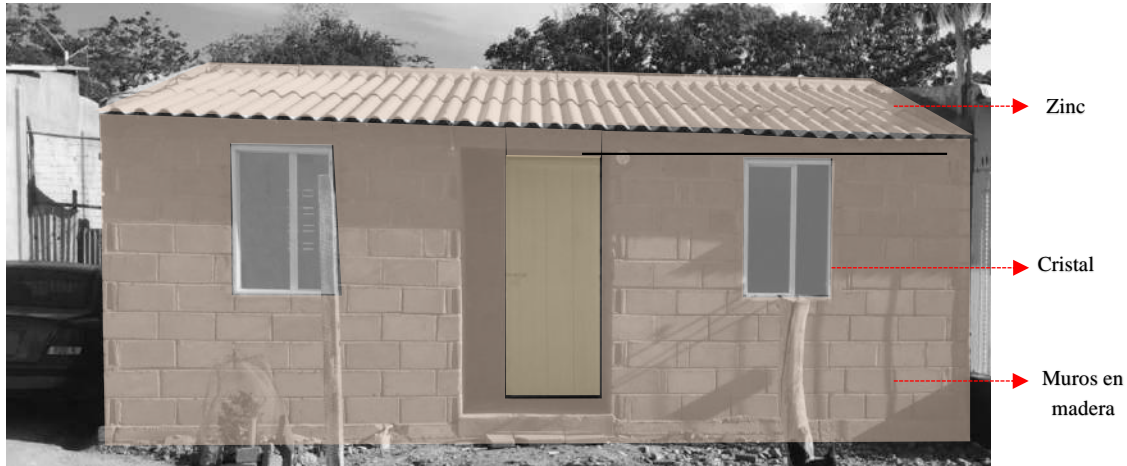
Imagen.22 Materialidad en viviendas prefabricadas
