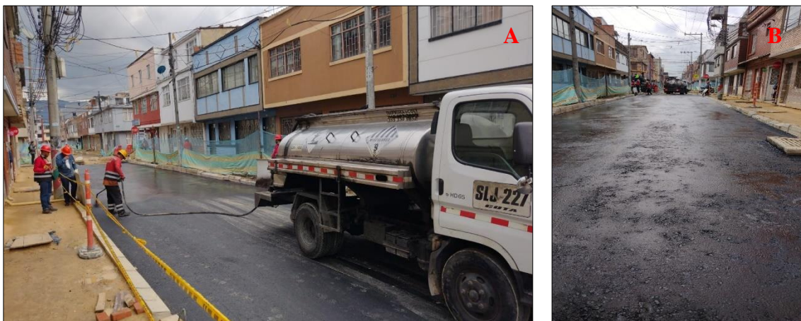
Figura 48. Proceso de riego de liga. Fuente: Propia
