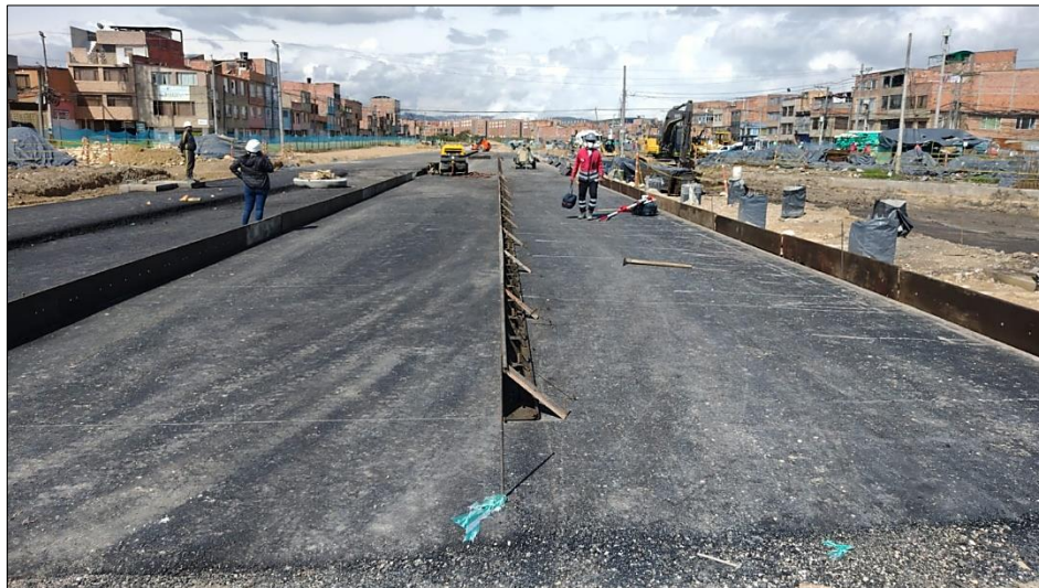
Figura 55. Compactación de la mezcla. Fuente: Propia
