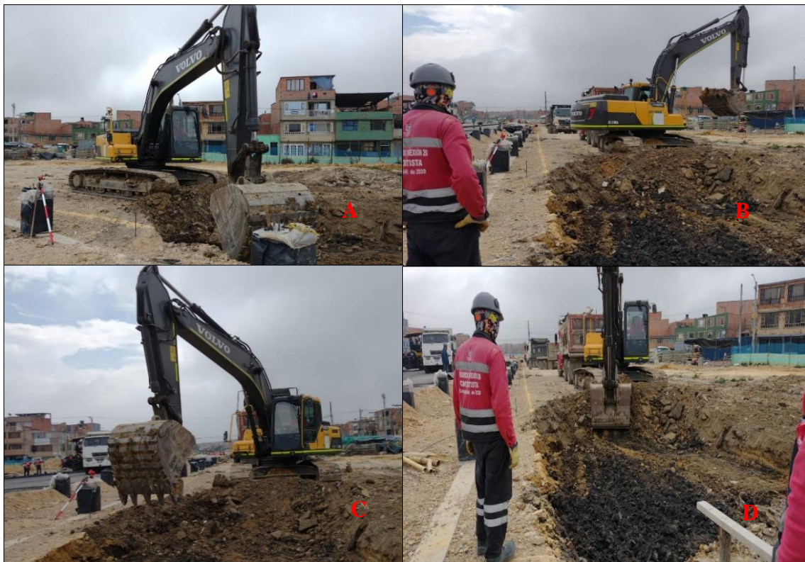
Figura 22. Excavación con la retroexcavadora de oruga en el tramo 1 de la calzada de Transmilenio de la Avenida
