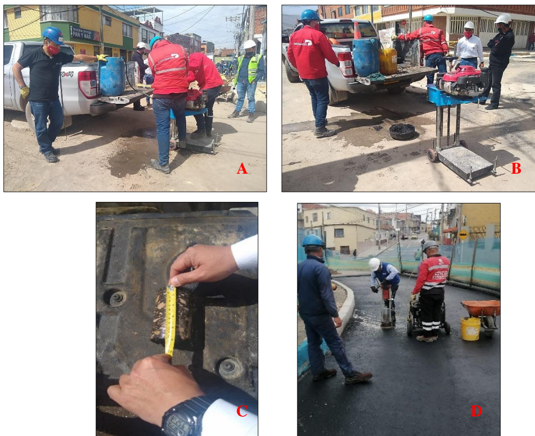
Figura 49. Extracción de núcleos. Fuente: Propia
