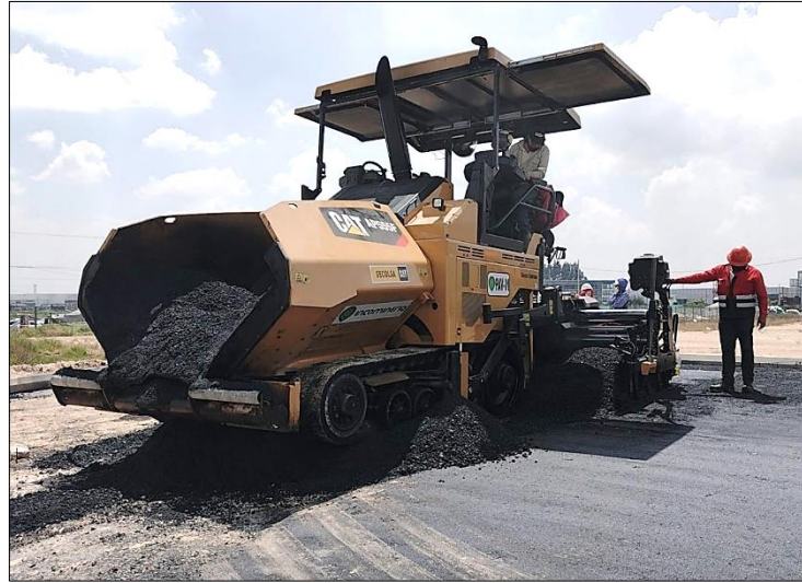
Figura 54. Extendimiento del asfalto con la maquinaria finisher. Fuente: Propia
