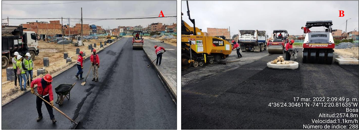
Figura 42. Compactación de un tramo de la vía en la zona de la Avenida Cali en la localidad de Bosa. Fuente:
