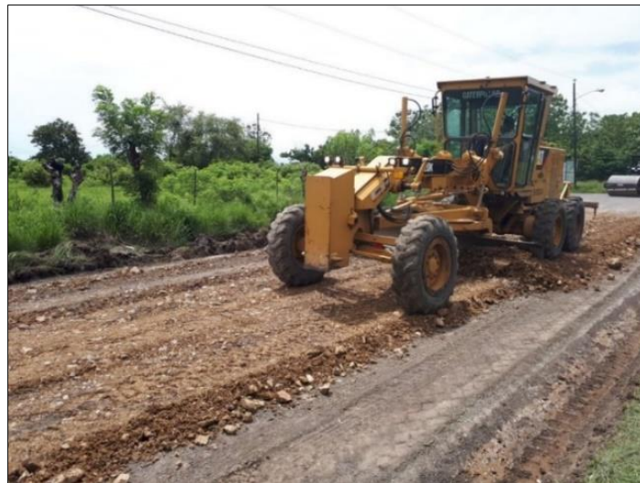
Figura 12. Extensión del material. Fuente: (Ortiz, 2017)
