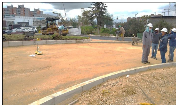
Figura 32. Ensayo con densímetro nuclear en el tramo 1. Fuente: Propia
