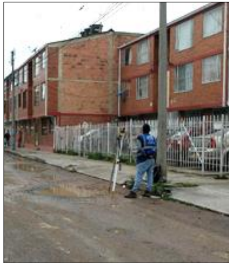
Figura 7. Localización y replanteo. Fuente: (Ortiz, 2017)
