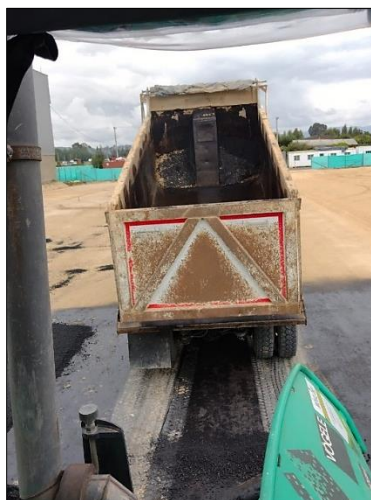
Figura 20. Volquete transportando material. Fuente: Propia
