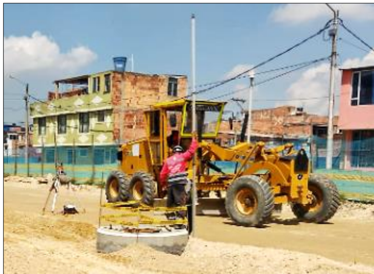
Figura 21. Máquina motoniveladora nivelando la capa granular. Fuente: Propia
