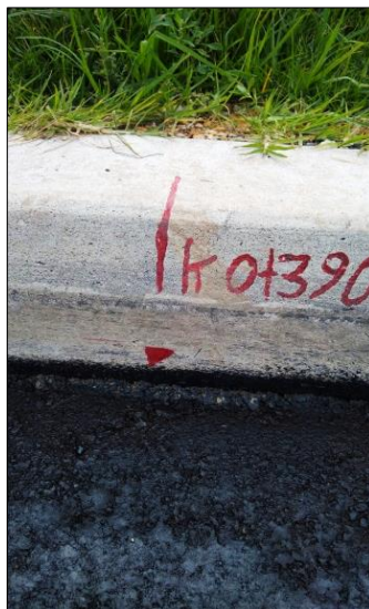
Figura 38. Niveleta que es el triángulo donde debe quedar terminada la rasante con su respectivo abcisado. Fuente: Propia
