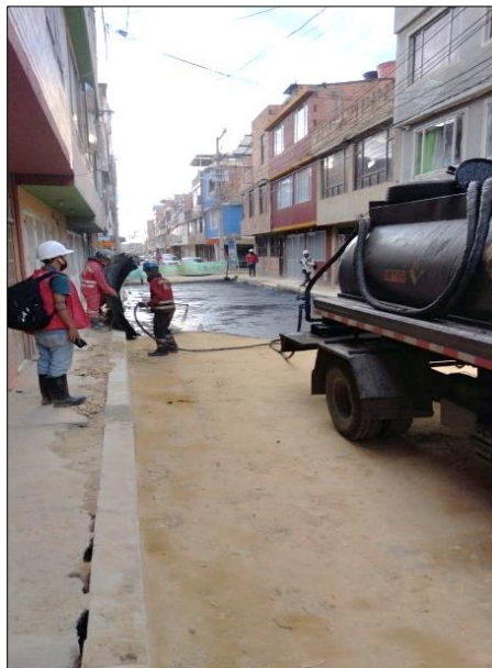
Figura 36. Aplicación de la emulsión asfáltica en la capa base. Fuente: Propia
