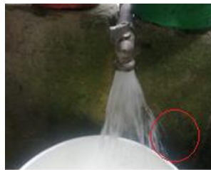
Figura 7. Desperdicio de agua por descuido en la sección de aseo.
