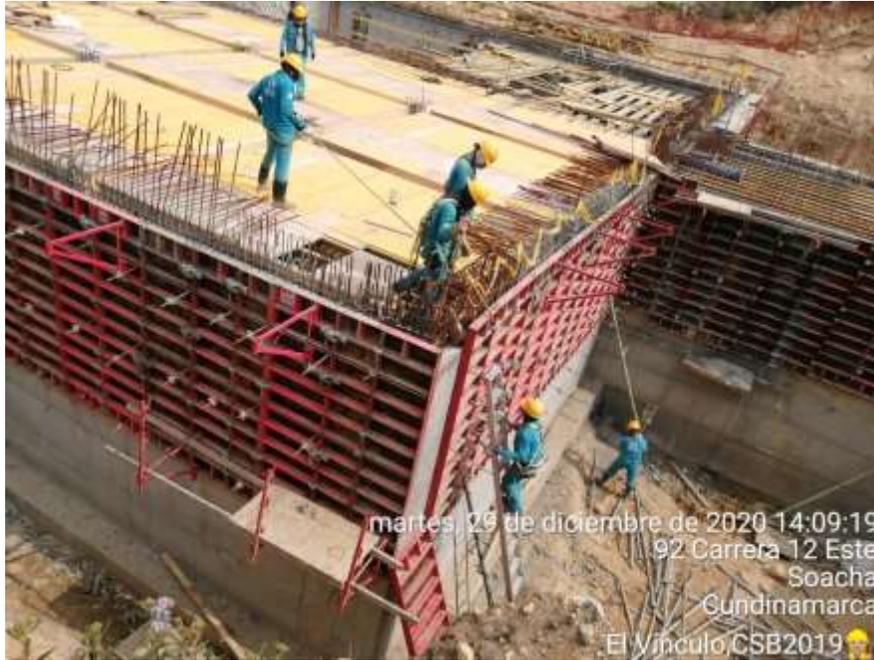
*Imagen 33. Fuente: Autor. Instalación de formaleta para colocación de bovedillas*
