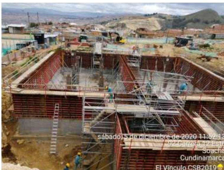
*Imagen 35. Fuente: Autor. Producto en etapa de culminación esperando tiempos de fraguado para retiro de formaleta sistema 1*
