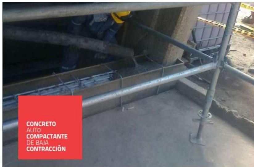
*Imagen 10. Catalogo soluciones CEMEX, concretos especiales (Auto- Compactante de baja contracción)*
