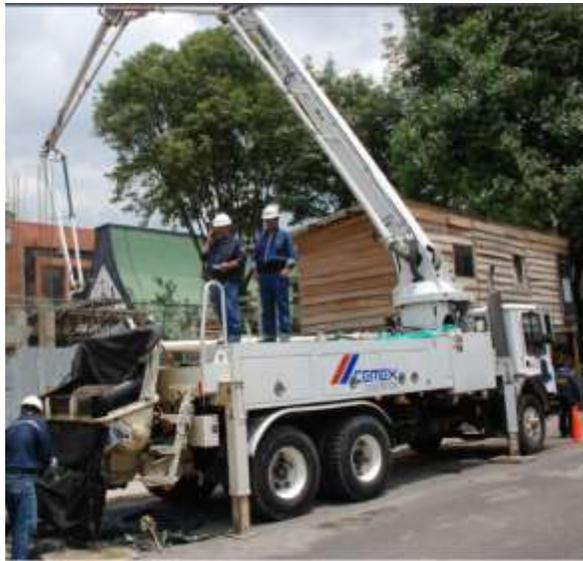
*Imagen 6. Catalogo soluciones CEMEX, concreto de resistencia a 28 días bombeado*
