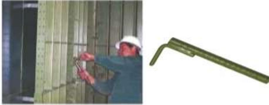
*Imagen 29. (FORMESAN, Guia practica para armar y desarmar, 2010) Corrección con herramienta manual (alineador)*
