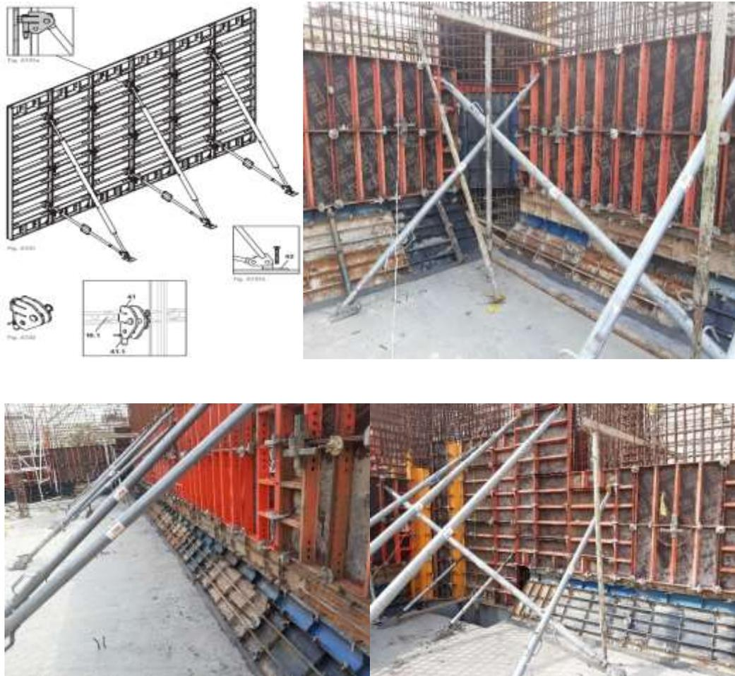
*Imagen 21. (LIWA, 2011) LIWA, encofrado modular. Instrucciones de montaje y uso para la configuración estándar (estabilizadores)*
