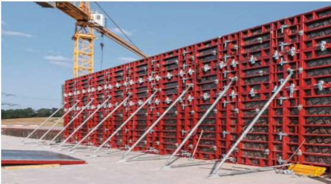
*Imagen 4. (LIWA, 2011) sistema 1 encofrados y andamios, encofrados para muros desarrollados por PERI*
