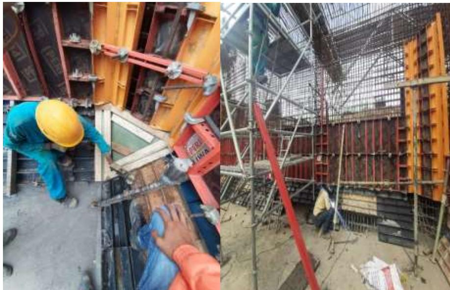
*Imagen 22. (LIWA, 2011) LIWA, encofrado modular. Instrucciones de montaje y uso para la configuración estándar (esquina articulada)*
