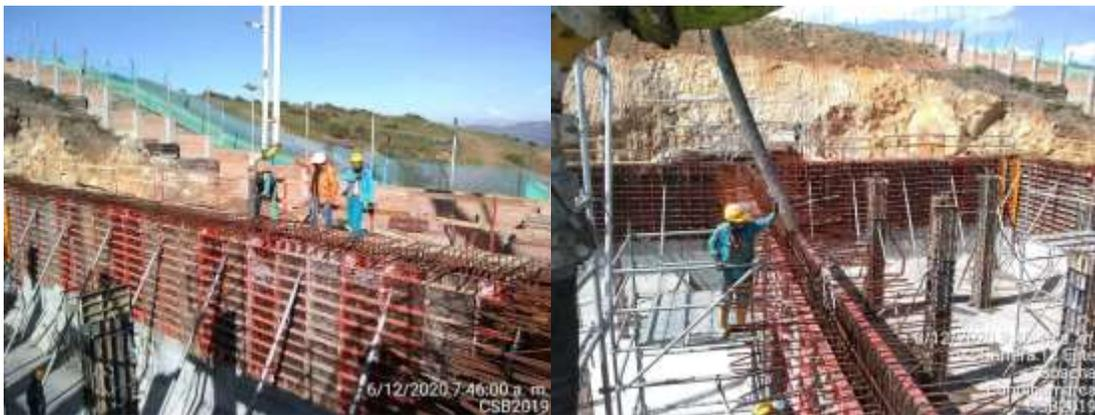
*Imagen 23. (LIWA, 2011) LIWA, encofrado modular. Instrucciones de montaje y uso para la configuración estándar (estabilizadores)*
