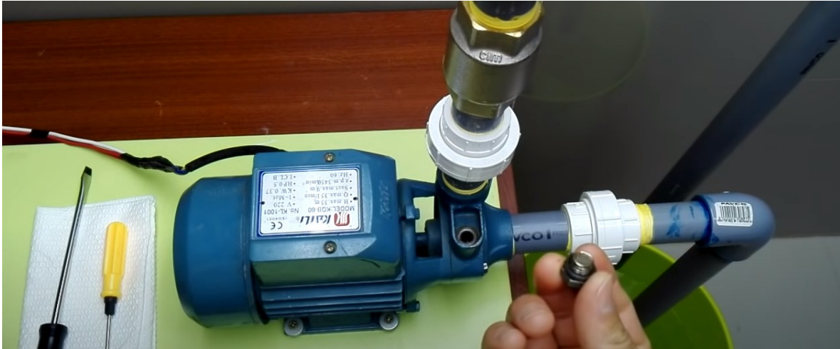
Figura 38. Conexión hidráulica de motobomba. Fuente: Propia.
