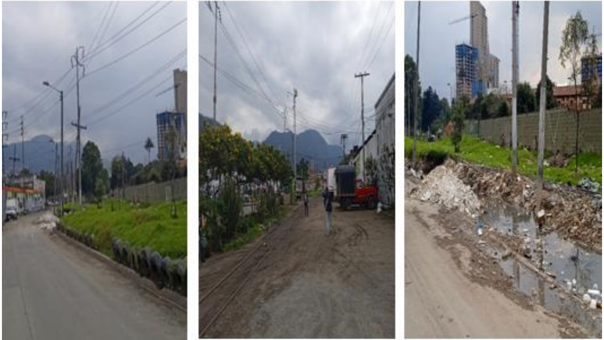
1.Calle diagonal 19ª carrera 26
