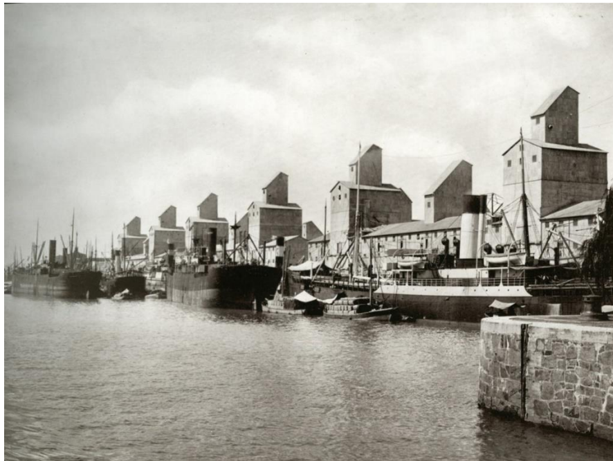
Imagen 10 Vista del Dique
