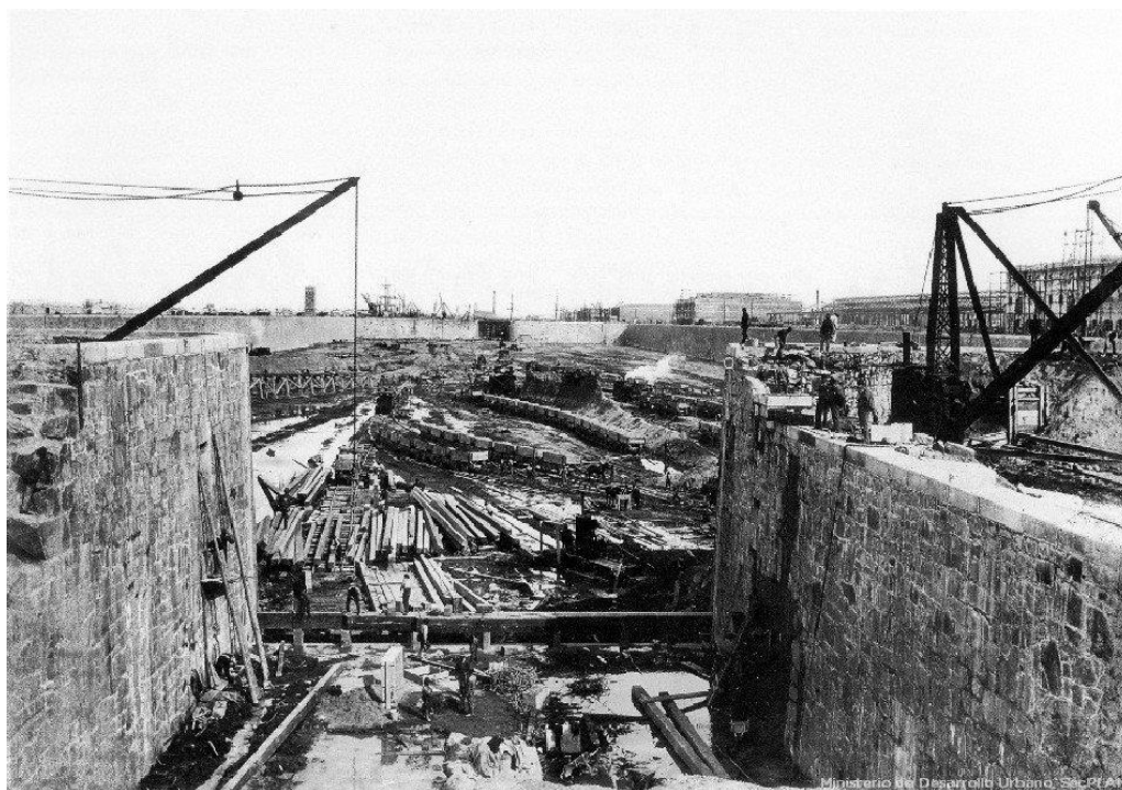
Imagen 11 Construcción de los Diques
