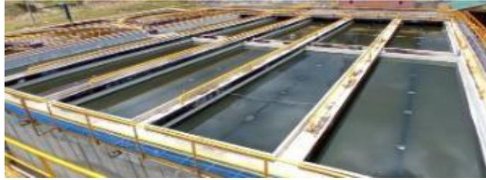
**Ilustración 12.** Reactores UASB PTAR Veolia Tunja.
