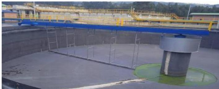
**Ilustración 13.** Sedimentador PTAR Veolia Tunja.
