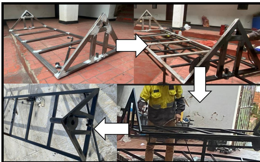
Figura 48. Detalle de proceso de recubrimiento de la estructura metálica
