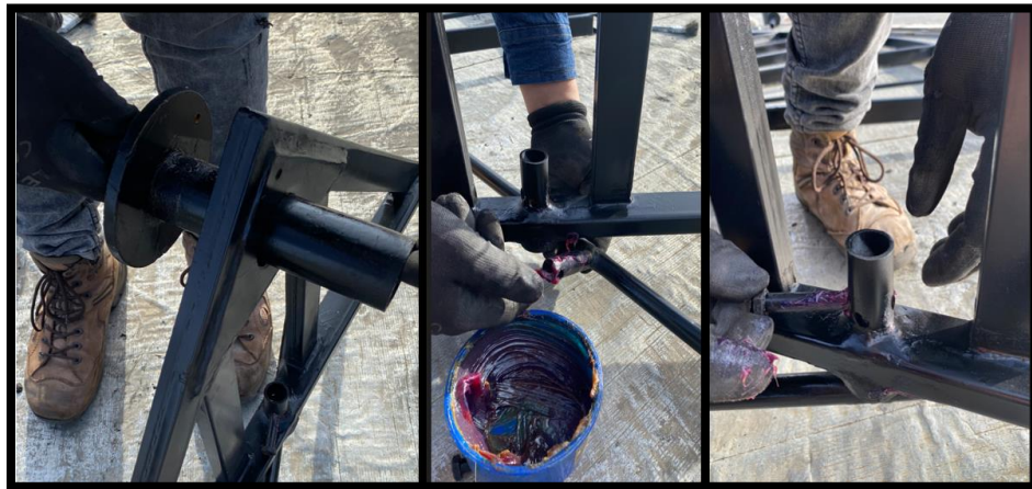
Figura 55. Engrase de encajes y tornillos pasantes de la estructura
