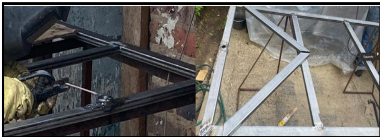
Figura 36. Construcción de la base del captador
