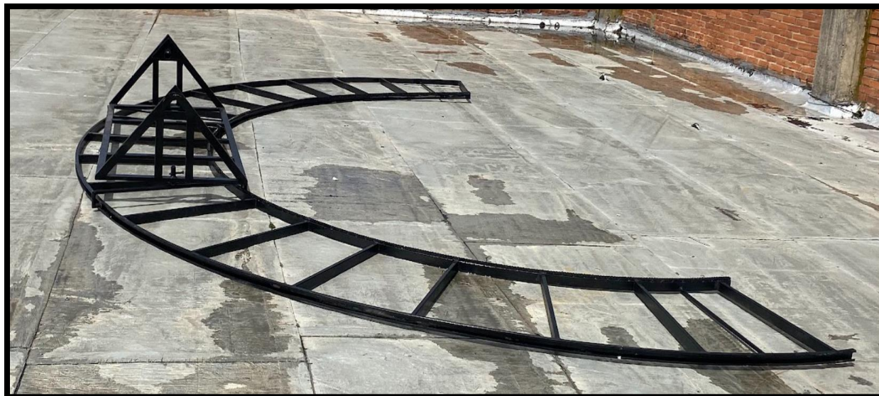
Figura 49. Estructura metálica terminada
