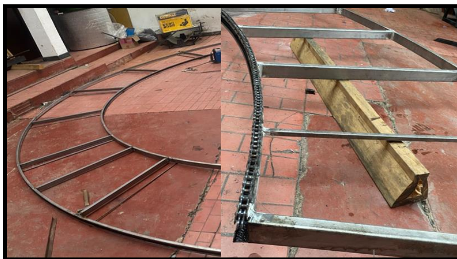
Figura 40. Ensamble de refuerzos y cadena en la estructura de rieles (autoría propia)
