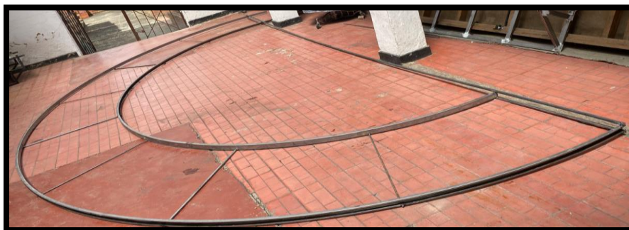
Figura 39. Fijación de las medidas de los rieles guía
