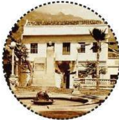
Construcción edificio nuevo en 1912
