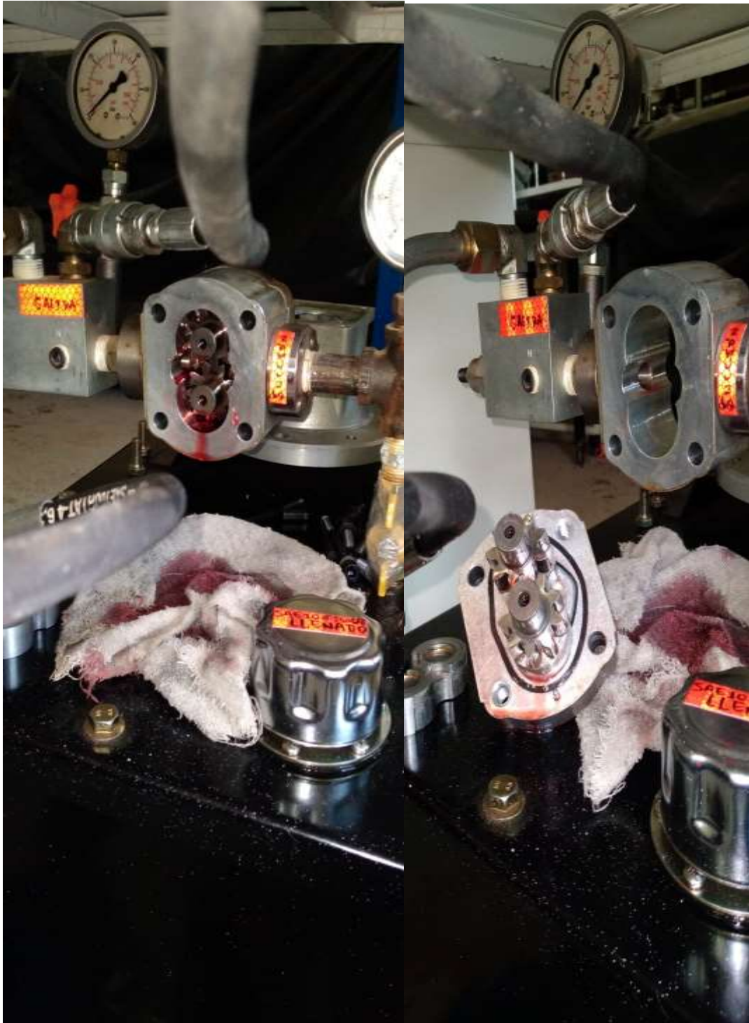
Desarme y limpieza de bomba hidráulica
