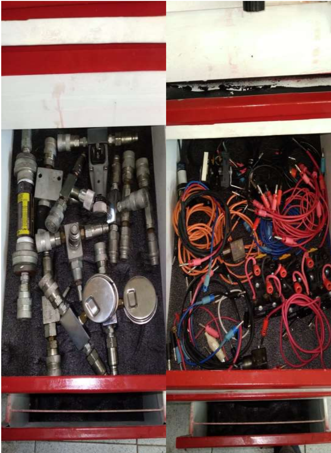
Organización de los accesorios hidráulicos, cableado y componentes eléctricos en los gabinetes
