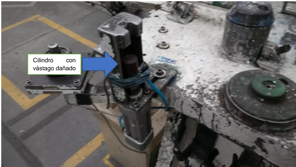
Figura 6. Cilindro e inyector de aire para prueba de estanqueidad
