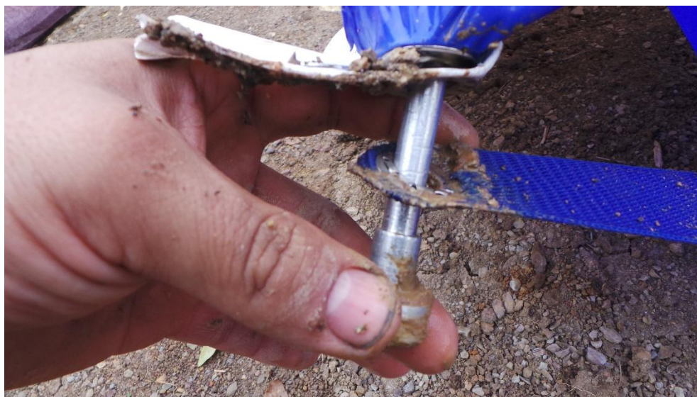
Fotografía 32. Ensamble de pines para tensar triangulo. Fuente propia
