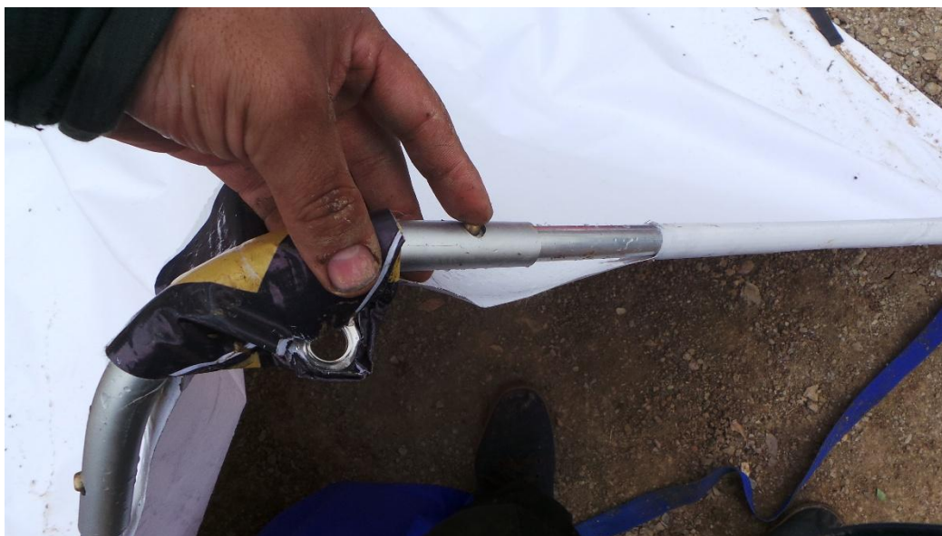
Fotografía 30. Ensamble de parales con arista para formar triangulo. Fuente propia
