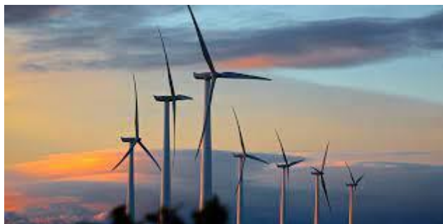
Figura 1-4. Aerogenerador vertical de 3 aspas
