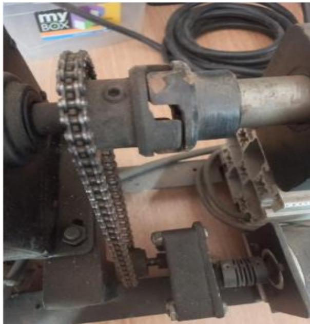
Fig. 7. Oxidación en piezas mecánicas, no permite el libre movimiento de las piezas.
