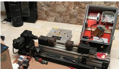
Fig. 10. Desmontaje de componentes eléctricos al interior del gabinete de potencia y control.
