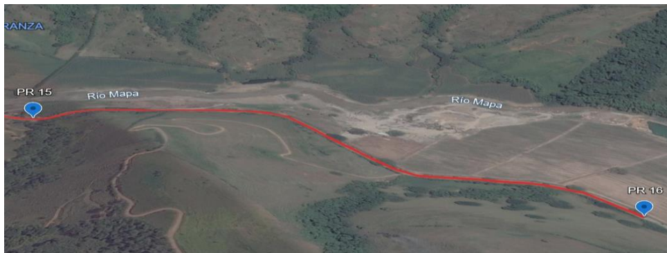
Figura 12. Vista panorámica y satelital tramo Apia - La Virginia PR 15 - PR 16.
