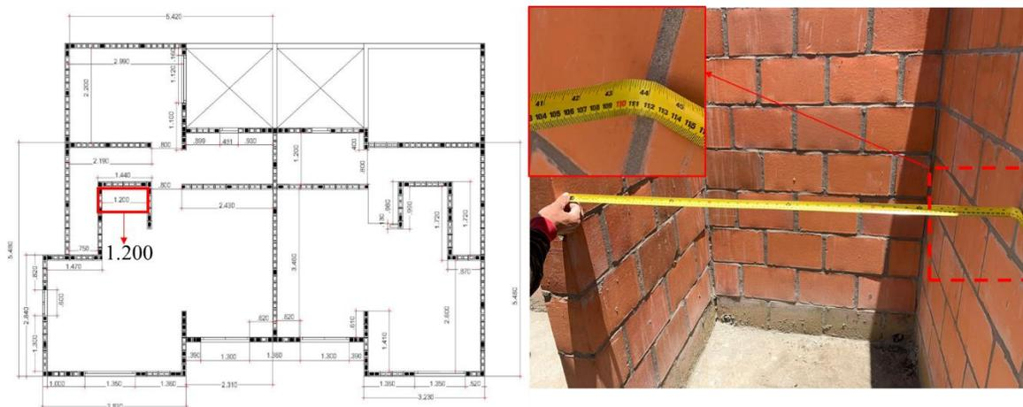
**Nota:** En el plano de la izquierda el closet se indica con una medida de 1.20 metros, pero en la realidad, la mampostería tiene una longitud de 1.12 metros.
