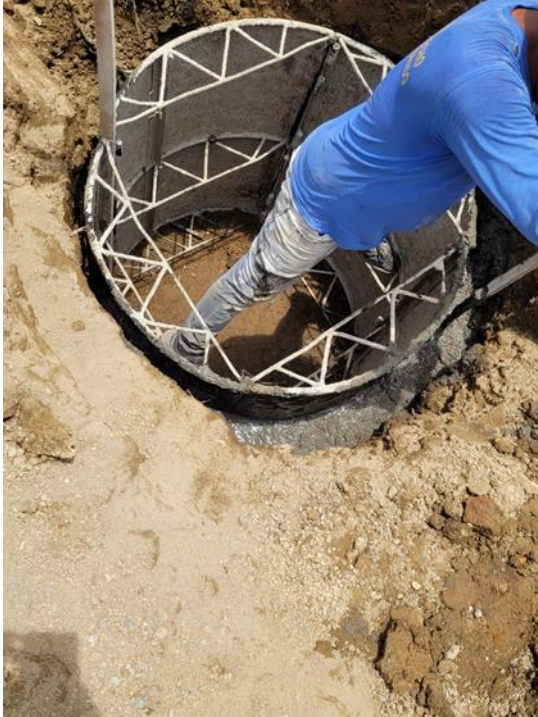
Figura 13. Construcción de cámaras de inspección.
