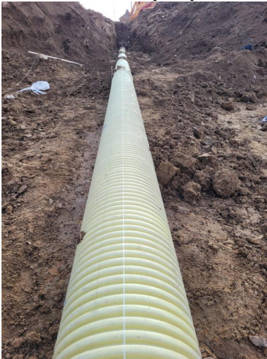
Figura 12. Instalación de tubería sanitaria principal.
