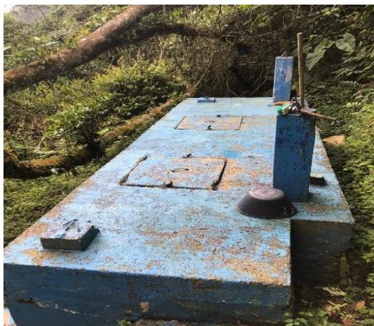
**Nota.** Tanque de sedimentación, este tiene como función remover y separar la arena y los restos de material sólido. **Fuente:** Elaboración propia.
