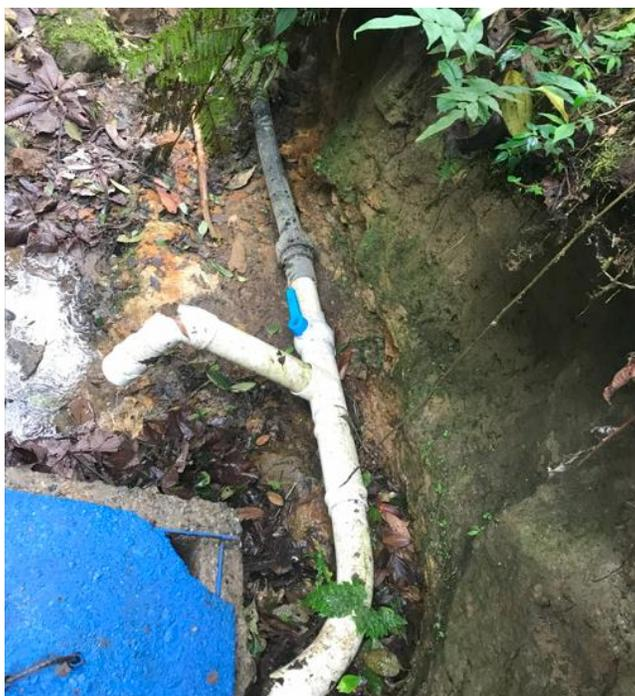
*Nota.* Tubería en PVS con conexión a tubería de polietileno con su respectiva válvula. **Fuente:** elaboración propia.
