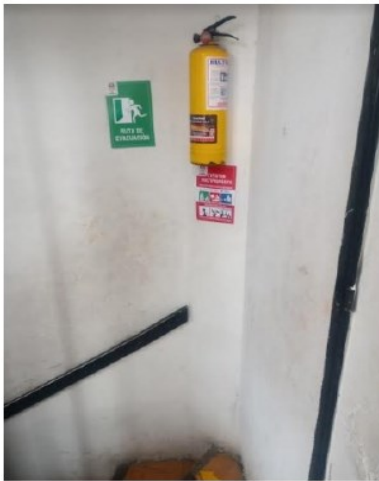
Escaleras cuarto piso
