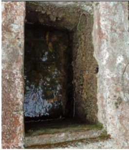
Figura 23: Formación de algas, Estado de oxidación de las escaleras, falta de mantenimiento
