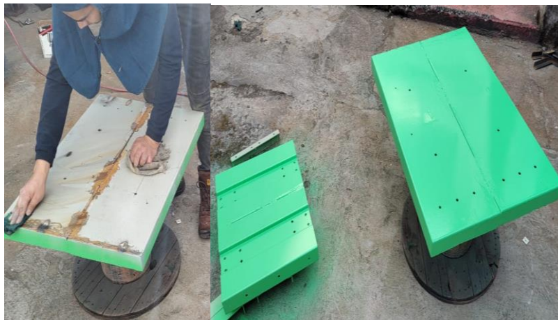
Figura 12. Bases para transformador y motor.
