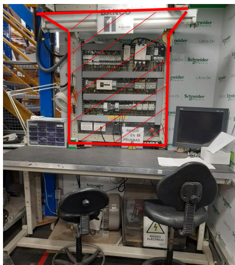
Figura 5. Identificación de partes a eliminar del banco.
