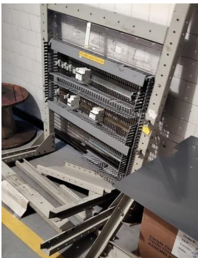
Figura 8. Estructura y equipos para la restauración.
