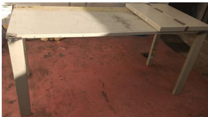
Figura 10. Construcción base del banco nuevo.
