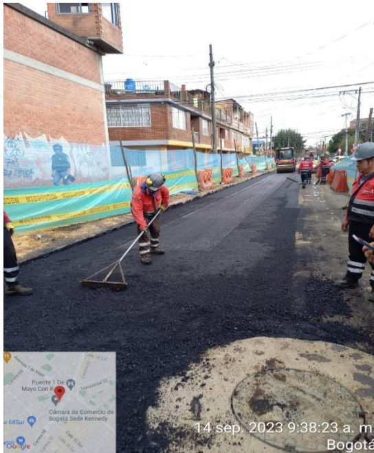
Figura 19 Instalación de MD-20
