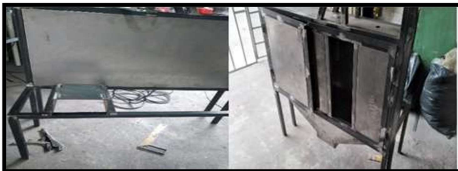
Figura 39 Contrición de estructura
