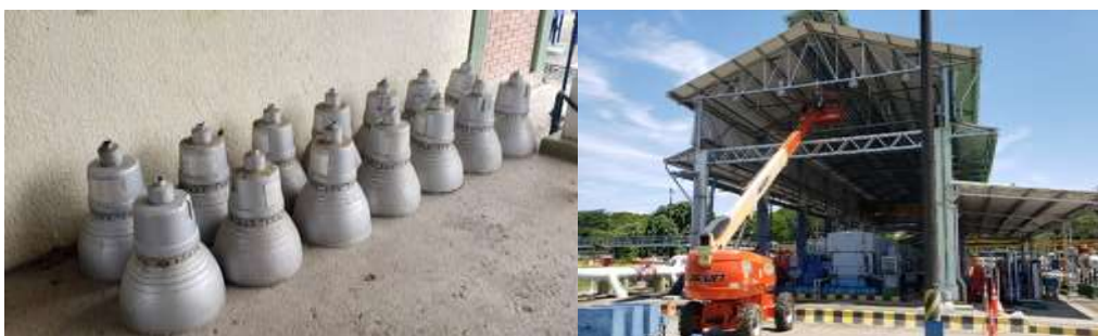
Figura 7-2 Desmantelamiento de luminarias tipo sodio
