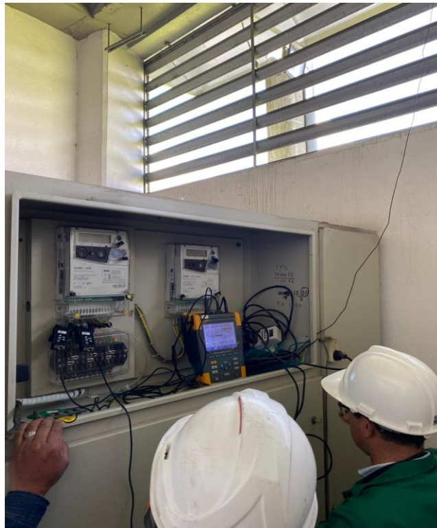
Figura 3 - Instalación de equipo en tablero en celda de medida de alta tensión
