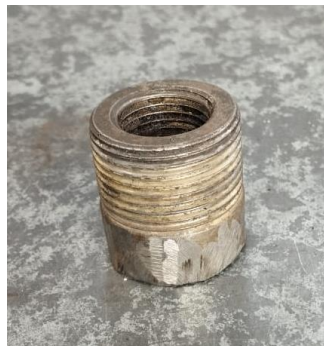
Fig. 4. Se procede a esmerilar el cuadrante del buche para que este pueda entrar en el tuve de transversal para ser soldado.
