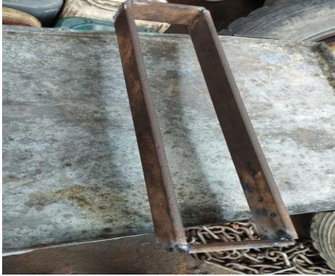
Fig. 12. Se cortan 2 platinas de 0.51 metros de largo y 2 platinas de 0.08 metros de largo para darle forma a la mesa de trabajo estas también son soldadas por el método de arco eléctrico (MMA),
