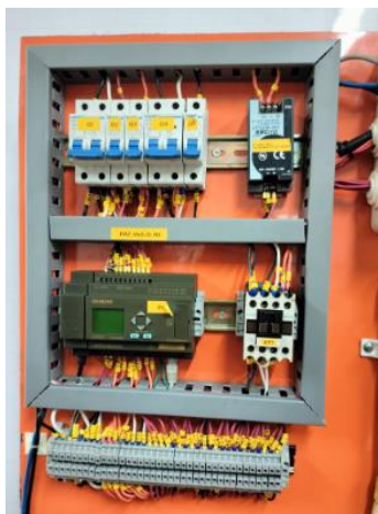
Fig. 28. Presentación del resultado de organización del cable en el panel de control
