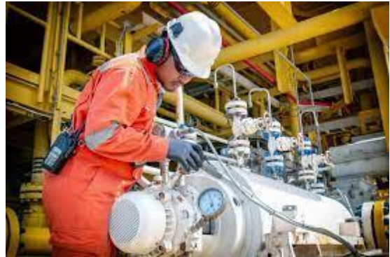
Fig. 2. Mantenimiento preventivo en bombas de trasiego.
