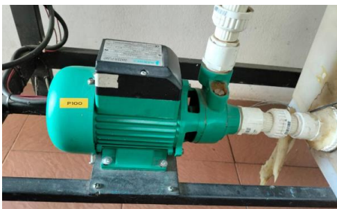
Fig. 11. Electrobomba centrífuga 0.5HP.
