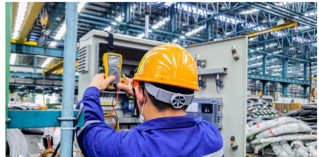
Fig. 1. Mantenimiento preventivo en gabinetes de control.
