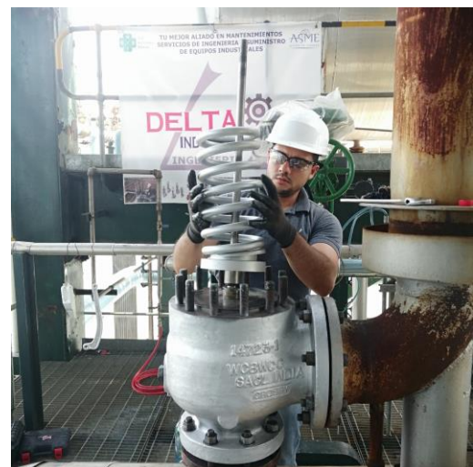
Fig. 3. Mantenimiento correctivo válvula de seguridad.
