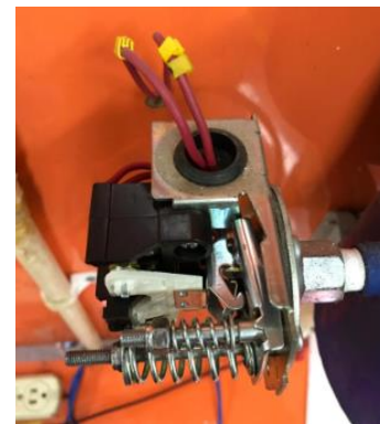
Fig. 8. Presostato PE102
