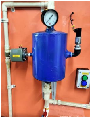
Fig. 24. Tanque pulmón restaurado
