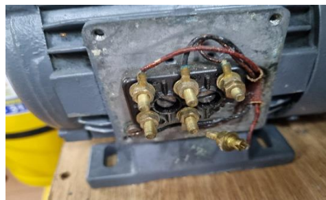
Fig.5. borneras motor trifásico del banco de control didáctico electromecánico de contactores para arranques de motores eléctricos trifásicos.
