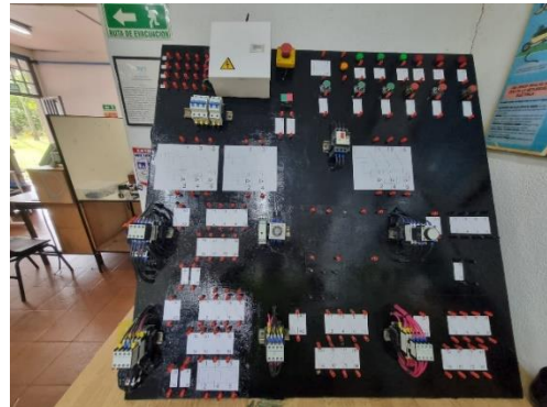
Fig.17 restauración tablero eléctrico del banco de control didáctico electromecánico de contactores para arranques de motores eléctricos trifásicos.
