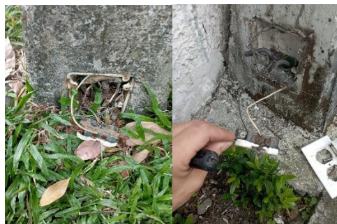
Fig. 3 instalación en postes de alumbrado
