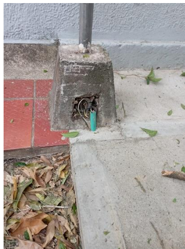
Fig.8 empalmes y terminaciones
