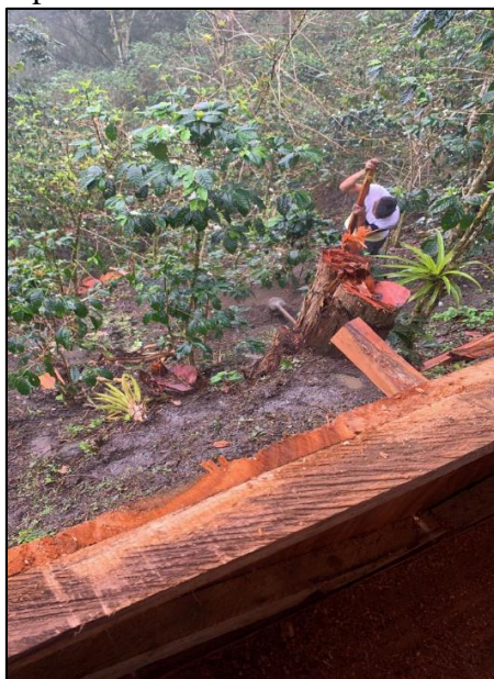
Figura 3. Modificación vivienda prefabricada Predio Rural 1 destinado para uso agrícola.
