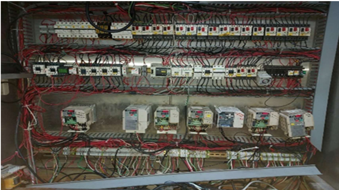
Figura 4. 10 Los arranques directos de los motores.
