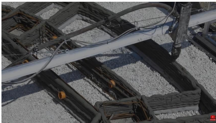
Figura 1. Encofrado de cimentación
