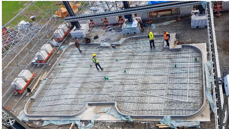
Figura 2. Encofrado de losa
