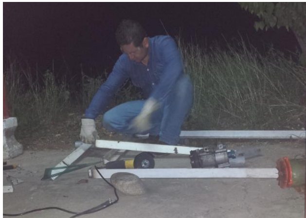
Figura 18: Corte de material.
