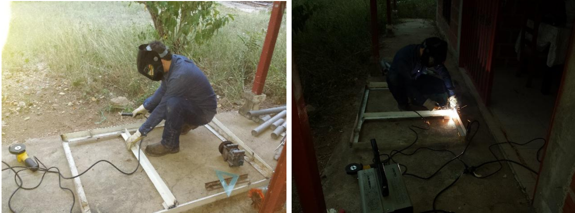
Figura 19: Soldaduras para unir las piezas del soporte.
