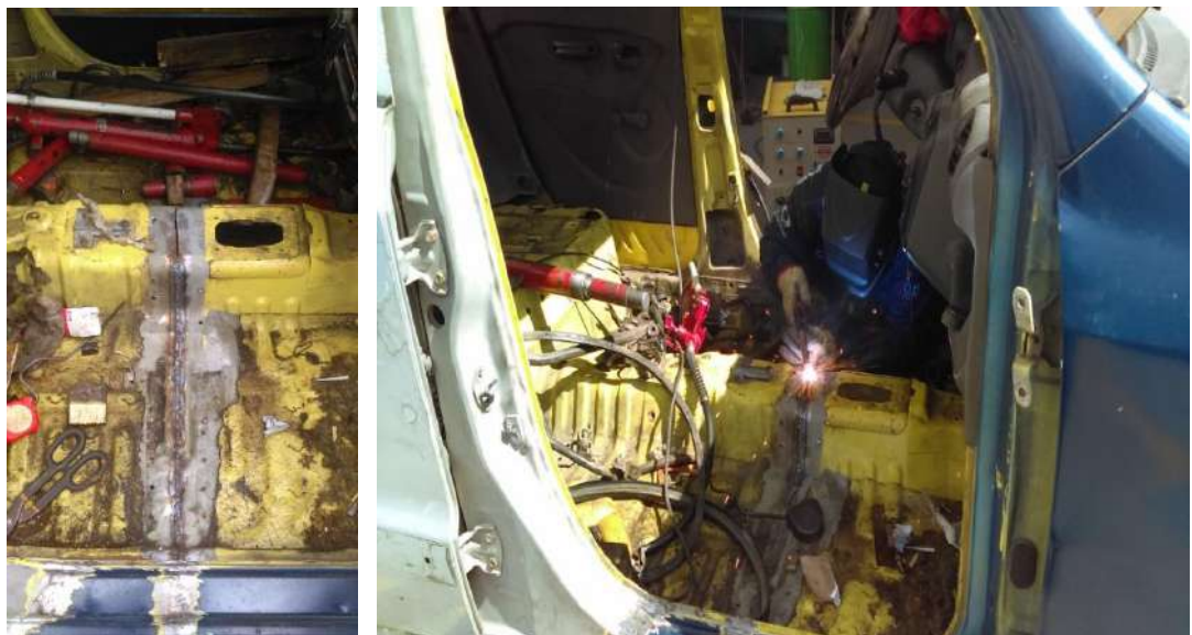
Figura 49. Ensamble de la carrocería parte trasera y delantera con soldadura MIG/MAG del banco de pruebas
