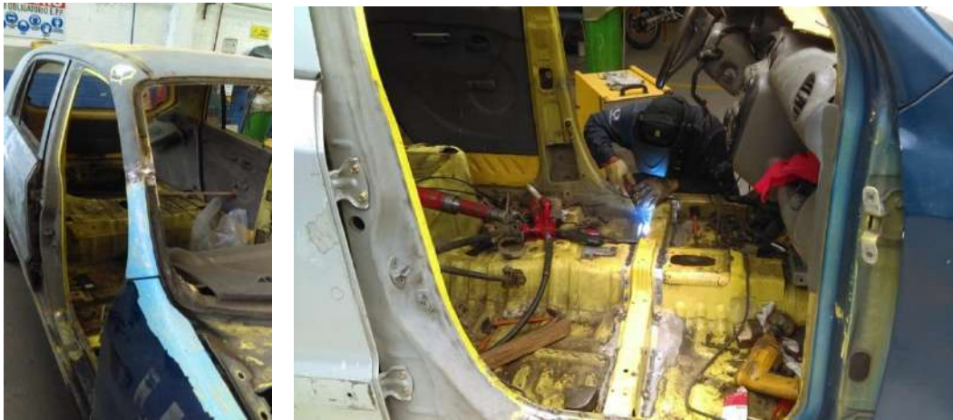
Figura 50. Ensamble de los parales y puente de refuerzo delantero con soldadura MIG/MAG del banco de pruebas
