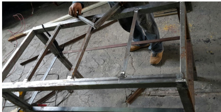
Figura 15. Estructura principal del banco
