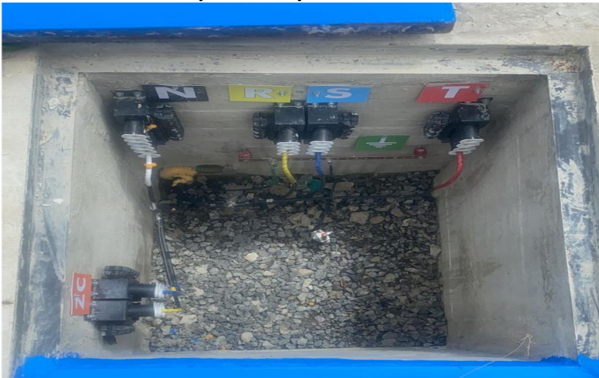
Figura 21 – Detalle armado red de baja tensión cajas subterráneas.
