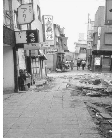
*Nota.* Asentamiento e inclinación de un edificio ubicado en Niigata, Japón. El edificio sufrió asentamiento e inclinación inducidos por la licuefacción durante el terremoto de Niigata el 16 de junio de 1964. (Fotografía de la Colección Steinbrugge, EERC, Universidad de California, Berkeley). Fuente: (Matsumoto et al., 2017)
