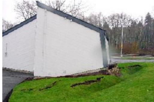
Fallos del terreno en los cimientos de estructura física ubicada al Sur Deschutes Parkway. Fuente: (Rivera, 2009)
