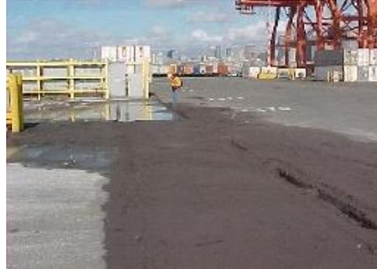
Burbujeo de arenas a lo largo de grieta de 100m de longitud con desplazamiento vertical de 13 cm. Fuente: (Rivera, 2009)
