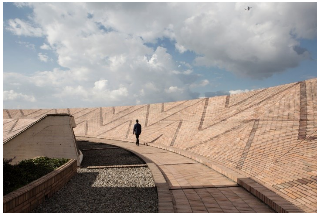
Figura 19 Vista de materiales de la biblioteca Virgilio (archdaily, 2020)
