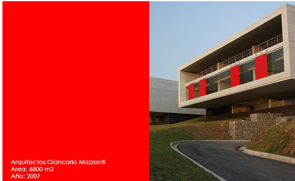
Figura 13. Parque Biblioteca León de Greiff, La Ladera, Fotografía Sergio Cortes
