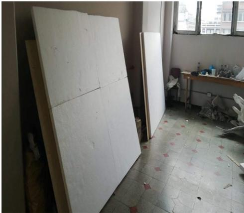
Después de la elaboración de bocetos, el paso a seguir es adherir las láminas de icopor de 5cm a las láminas de madera. Este procedimiento se realizó aplicando una mezcla de componentes del poliuretano expandido.
