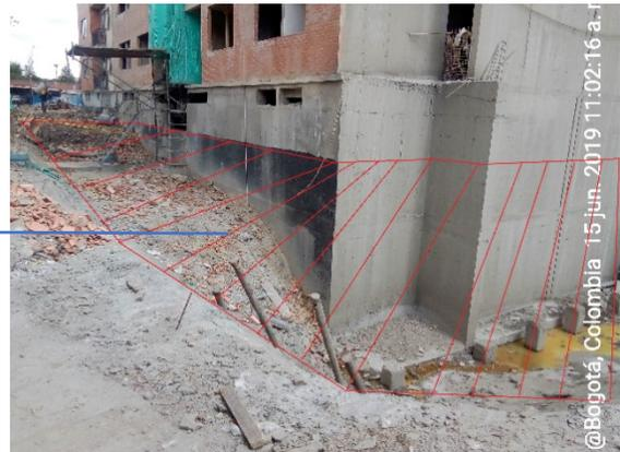
Nivelación del terreno utilizando residuos de concreto, ladrillo y bloque.
