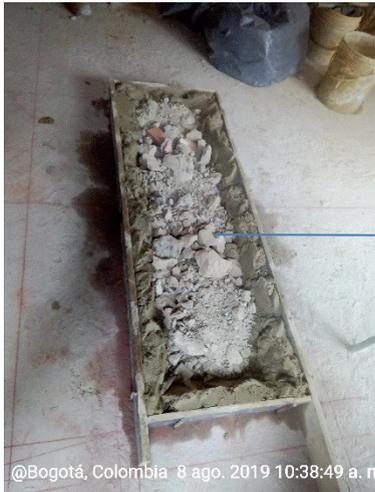
Lleno de sobre pisos con escombros para disminuir el consumo de materiales y la generación de RCD
