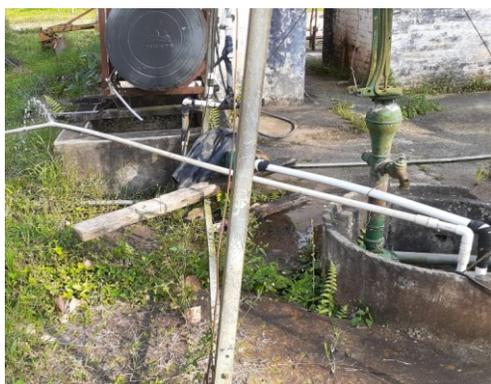
Foto 20. Purga mediante bombeo en el piezómetro PM26\_PZ8.
